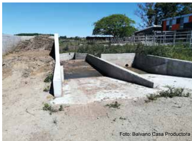
Figura 2 - Desarenador y separador de sólidos pasivo. Escuela Superior de Lechería de Nueva Helvecia, CETP-UTU.
